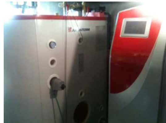
Inertzia depositua eta biomasa galdara
