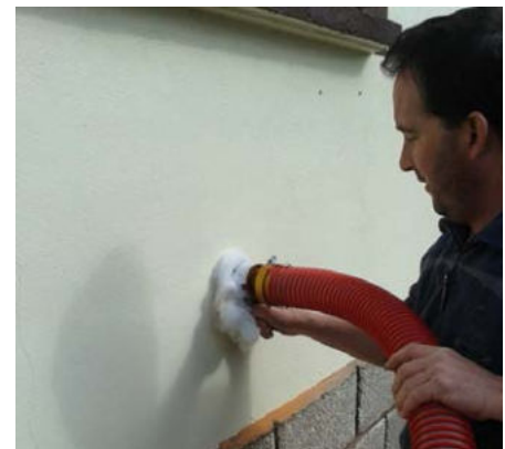
Fatxadan zelulosa injektatzen
