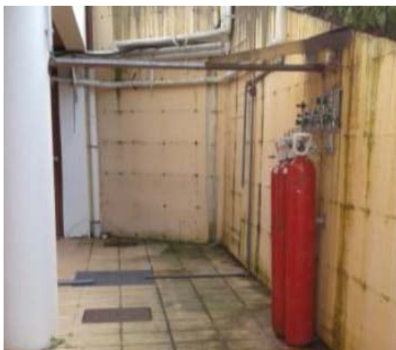
Hidrogeno-pilaren instalazioa
