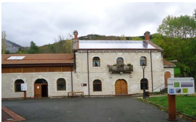
Araiaiko San Pedroko zentral hidroelektrikoa
