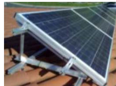
Eguzki-panel fotovoltaikoa, H 2 pila hkargatzeko.
