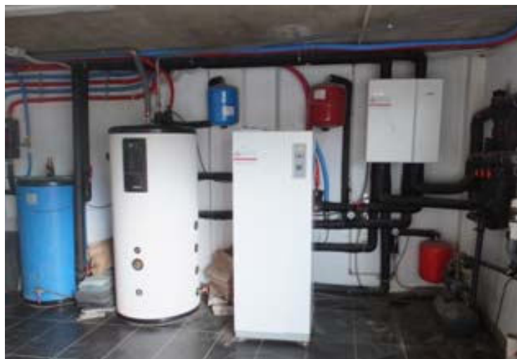
Bero ponpa geotermiko baten irudia
