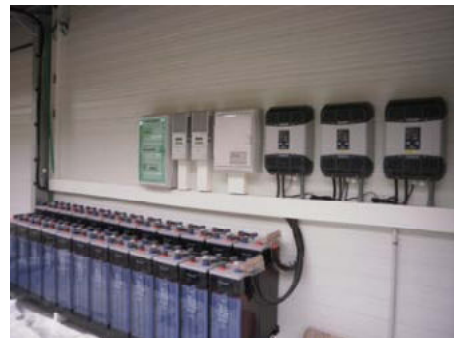
Babes, erreguladore, inbertsore eta bateria-sailaren koadroa
